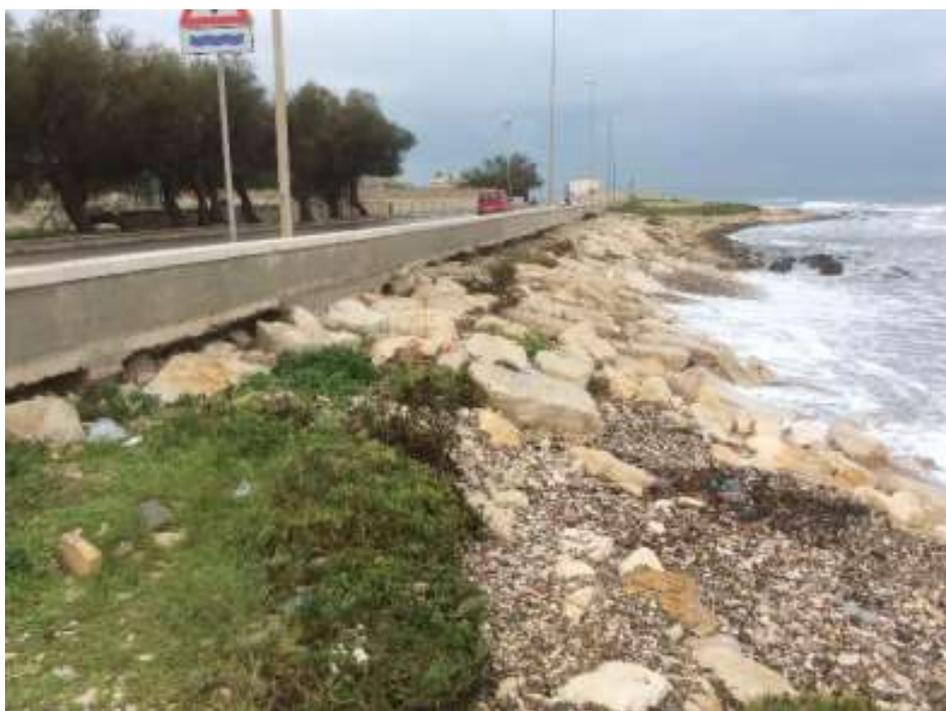
*Figura 26: Piccole cavità e scalzamenti alla base della sede stradale e interventi di sistemazione con scogliere artificiali già realizzati*
