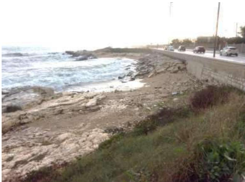
*Figura 27: Piccole cavità e scalzamenti alla base della sede stradale e interventi di sistemazione con scogliere artificiali già realizzati*
